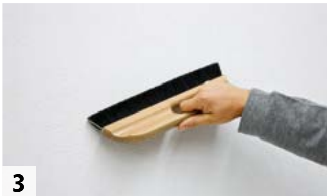
3 Relieftapete mit der Tapezierbürste blasenfrei andrücken und glattstreichen
