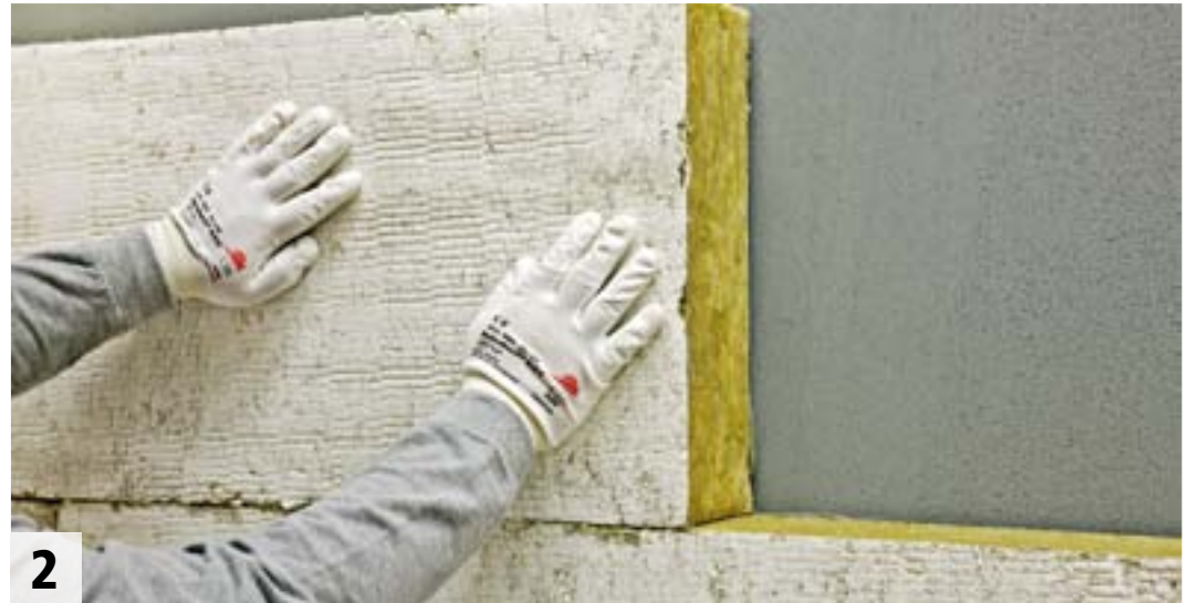
2 Dämmplatte andrücken
