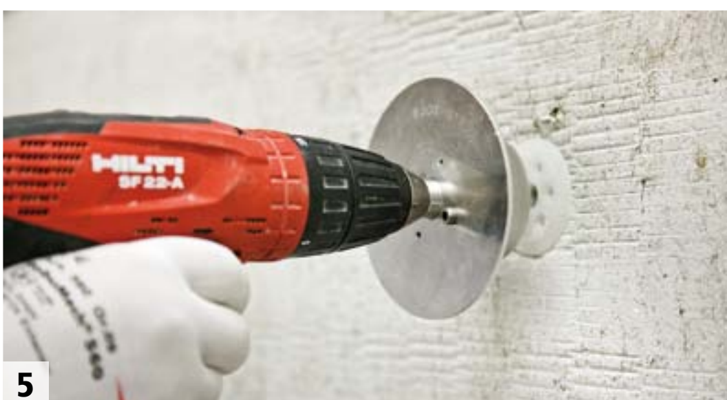
5 Schraube mit Montagewerkzeug einschrauben
