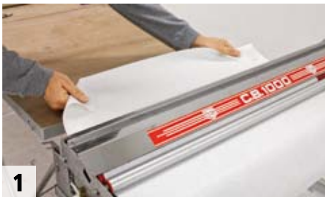
1 Kleister mittels Tapeziermaschine auf StoTap Infinity auftragen
