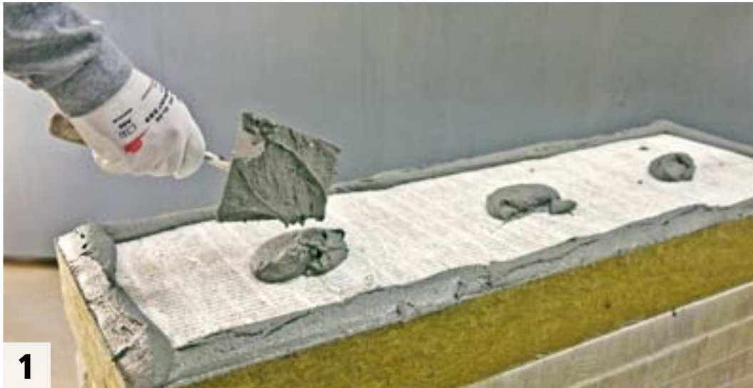
1 Sto-Baukleber im Punkt-Rand-Verfahren auf die Sto-Steinwolleplatte 035 Xtra II auftragen
