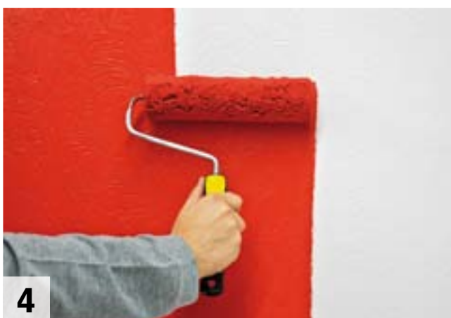
4 StoColor Opticryl mit der FIL-Walze auftragen
