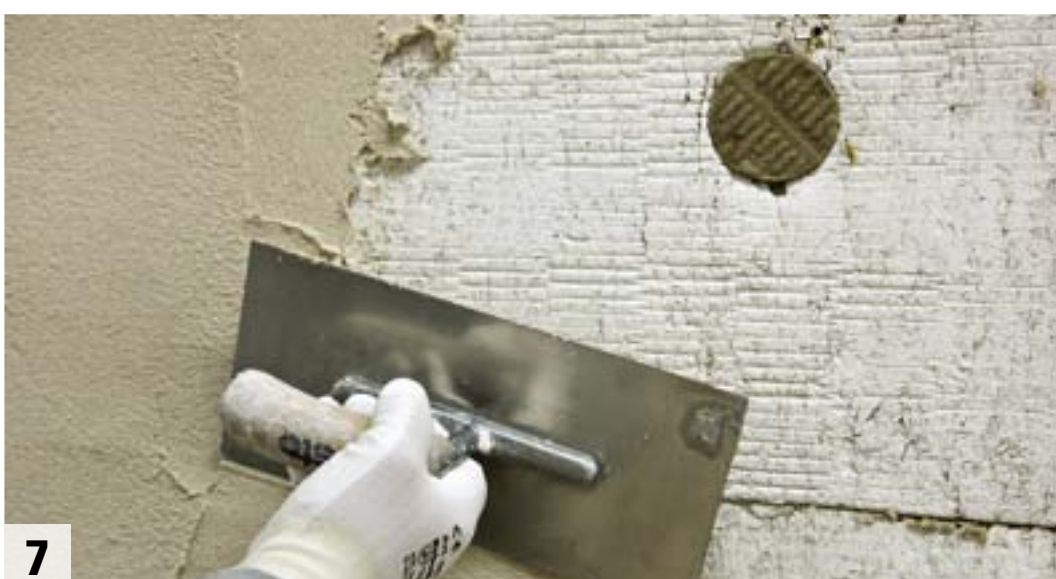
7 Dämmplatte mit StoLevel Uni armieren
