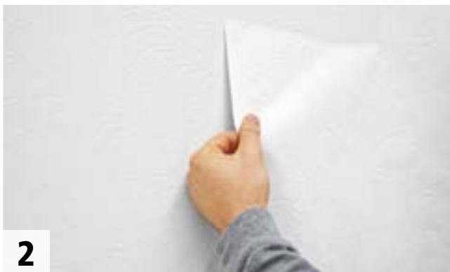
2 Die einzelnen Bahnen der Relieftapete auf Stoß verkleben
