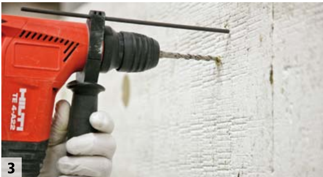
3 Dübelloch bohren
