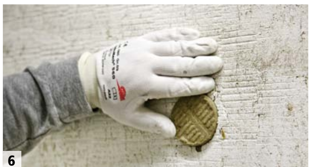
6 Dämmstoffrondell einsetzen
